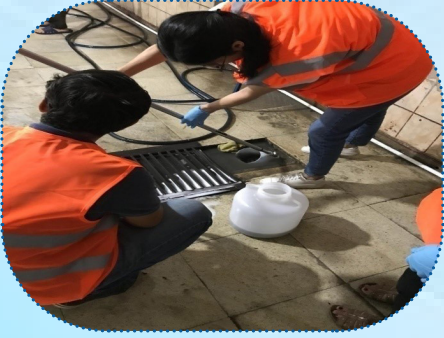
Ön Arıtma Sisteminin Kontrolü
