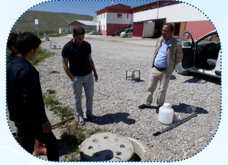
Ön Arıtma Sisteminin Kontrolü
