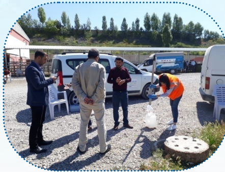
Ön Arıtma Sisteminin Kontrolü
