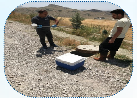
Ön Arıtma Sisteminin Kontrolü
