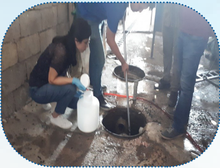
Ön Arıtma Sisteminin Kontrolü
