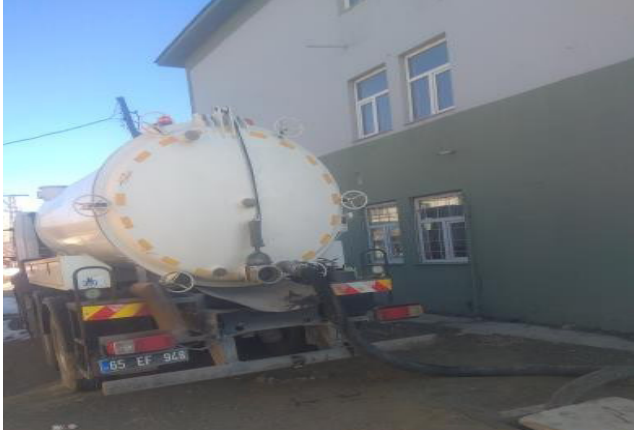
Resim 5: Basınç Aracı Marifetiyle Kanal Açma
