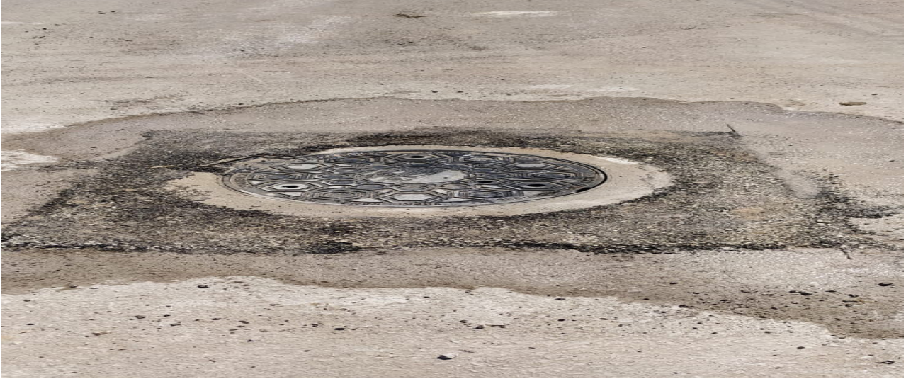
Resim 2: Muayene Bacası Yükseltme Çalışması
