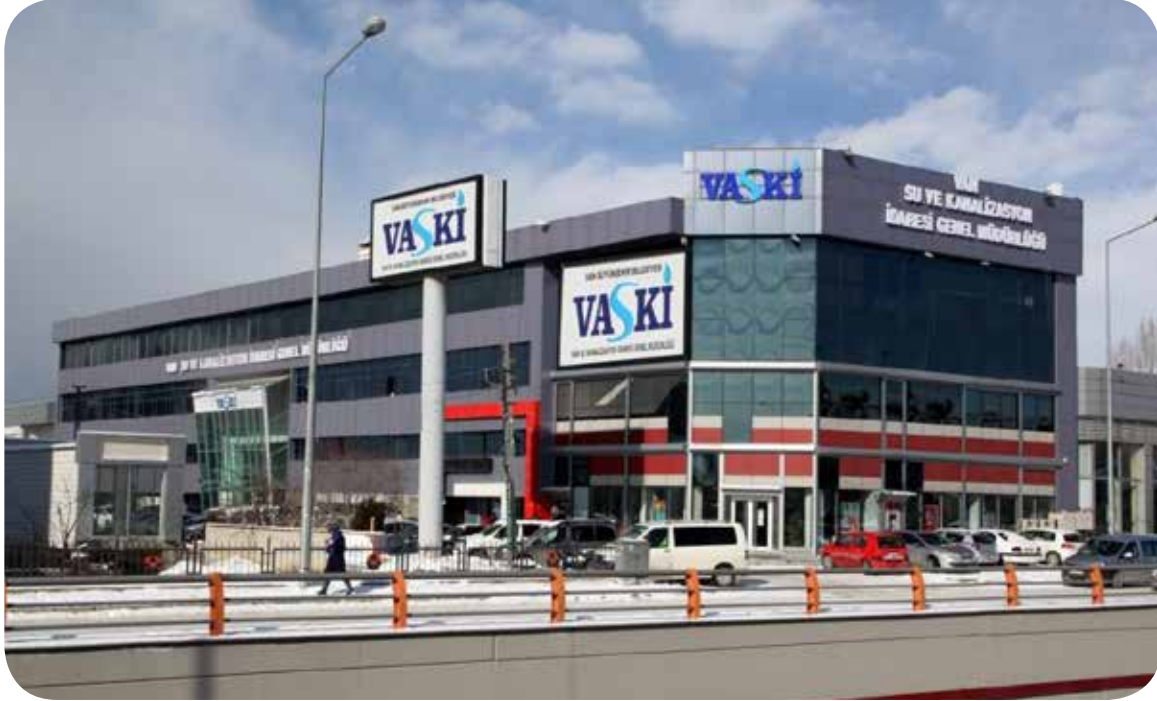
Merkez Hizmet Binası
