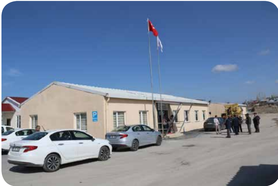
Tuşba (Altıntepe) Hizmet Binası
