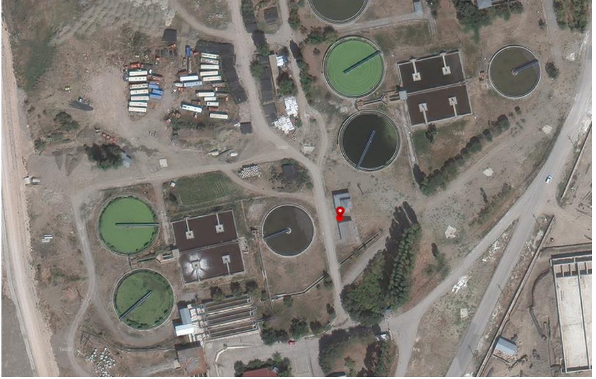
İskele Atıksu Arıtma Tesisi: 2022 Yılında tesis yıkılmış olup, faaliyetleri VAN MERKEZ İLERİ BİYOLOJİK ATIKSU ARITMA TESİSİ aracılığıyla yürütülmektedir.
