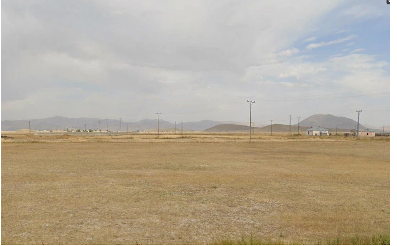
Çaldıran İleri Biyolojik Atıksu Arıtma Tesisi: Tesisin İnşaat Faaliyetleri devam etmektedir.
